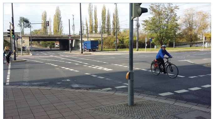
Obr.3. Zrušený přejezd pro cyklisty, který ústí do přidruženého prostoru. Nově je infrastruktura pro cyklisty řešena v hlavním dopravním prostoru, autor: Zbyněk Sperat
