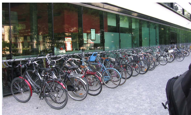
Parkovací stojany pro jízdní kola před SihlCity. Stojany jsou navrženy s opěrkou řídítek, která je ve dvou výškových úrovních, aby byla zajištěna maximální kapacita parkování na daném prostoru. Stojany jsou vybaveny ocelovým lankem, ke kterému se kolo zamyká
